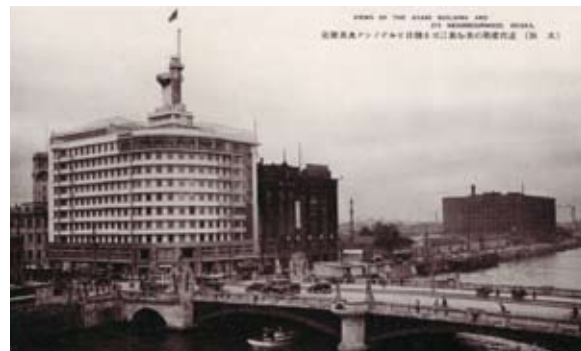
朝日ビルディングと朝日会館
